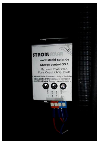
Der Solarregler (B). Gut sichtbar vorne in der Klappe,
