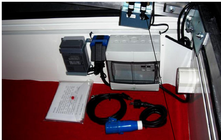
Im Ablagefach, vorne im Anhänger: Der Verteilerkasten (T), darin der Sicherungsautomat und der Personenschutzschalter. Daneben die Steckdose 220 Volt (S) und das Dryfit Ladegerät (Z). Oberhalb des Verteilerkastens sehen Sie die Steckerleiste (I). Hier können Sie wählen, ob Sie vom Ladegerät oder von der Solaranlage laden möchten. Und natürlich, ob Sie den Anschluss im Anhänger oder hinten außen verwenden.
