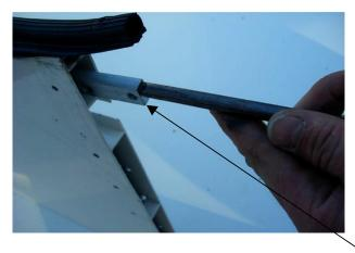
Stecken Sie einen Schraubenzieher in das mittlere Loch, damit der Klotz mit dem Einschraubgewinde nicht zu tief geschoben wird, wenn er in die obere Kammer der Seitenwand mit einer dünnen Holzstange oder einem dünnen Rohr (ca. 4m lang) bis zur Montagestelle gedrückt wird.
