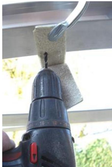
Legen Sie dann die Rampe hinten hoch, zum Beispiel auf einen Stuhl. Danach bohren Sie beide Scharniere, möglichst nahe im Bereich des linken Randes der rechten Schiene durch, bis in die Hohlkammer der Schiene.
