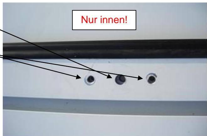
3. Stecken Sie einen Schraubenzieher in das mittlere Loch, damit der Klotz mit dem Einschraubgewinde nicht zu tief geschoben wird, wenn er in die obere Kammer der Seitenwand mit einer dünnen Holzstange oder einem dünnen Rohr (ca. 4m lang) bis zur Montagestelle gedrückt wird.
